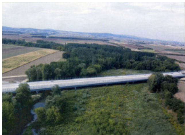
Die Leithabrücke - mit 410 m das längste Brückenobjekt im Zuge der A 6
