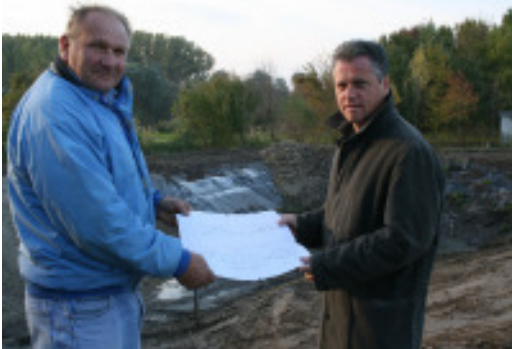
Bürgermeister Johann Köck und Polier Johann Vratny von der Fa. Leithäusl bei der Ausführungsbesprechung
